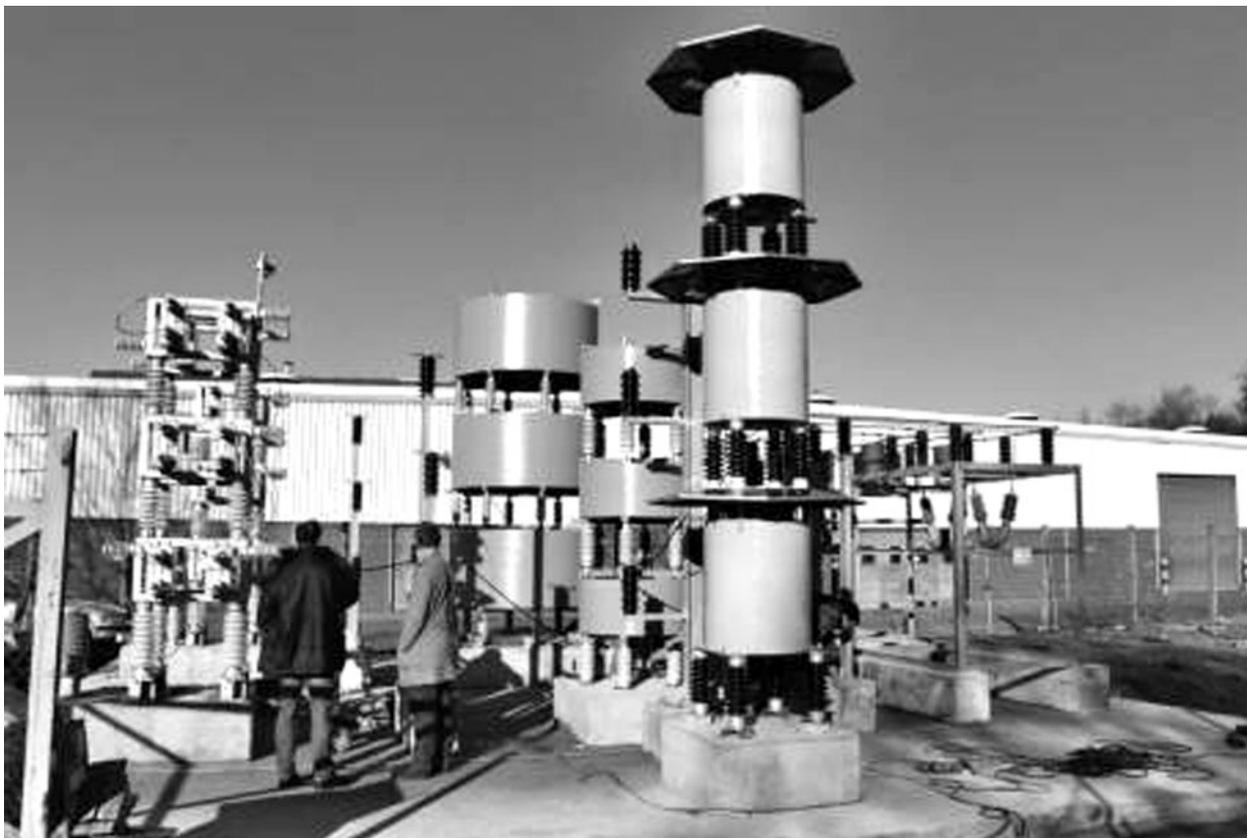
30kV-Freiluftanlage: 2-stufige Filterkreise 6Mvar mit Bedämpfungswiderständen (Hochpass)
